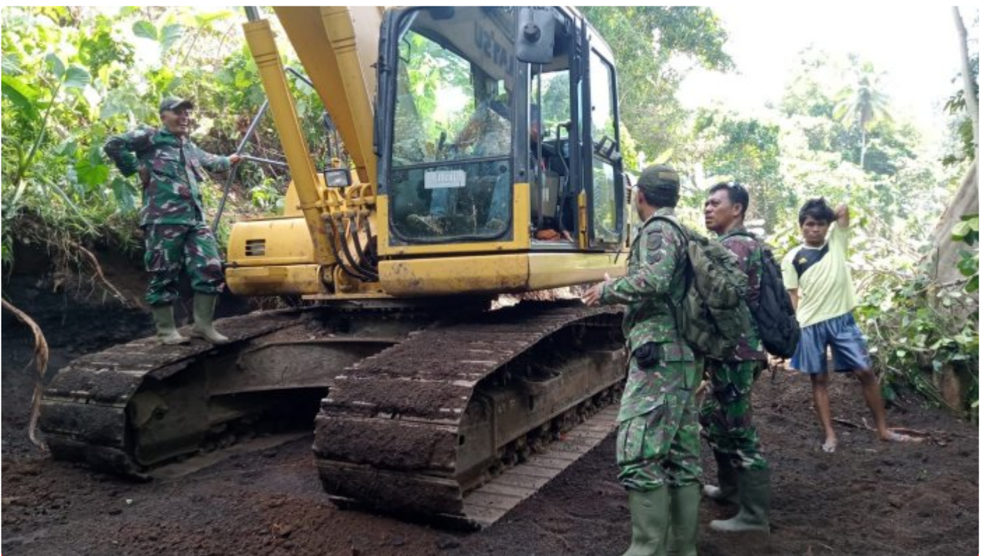
Ribtisan Jalan Pertanian pada TMMMD Ke-116 Tahun 2023 Kodim 1310 Bitung
