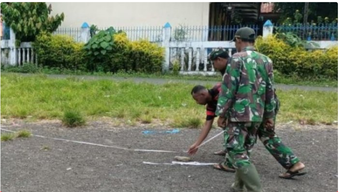
Satgas TMMD Lakukan Pengukuran Pembangunan Sarana Olahraga Jogging Track
