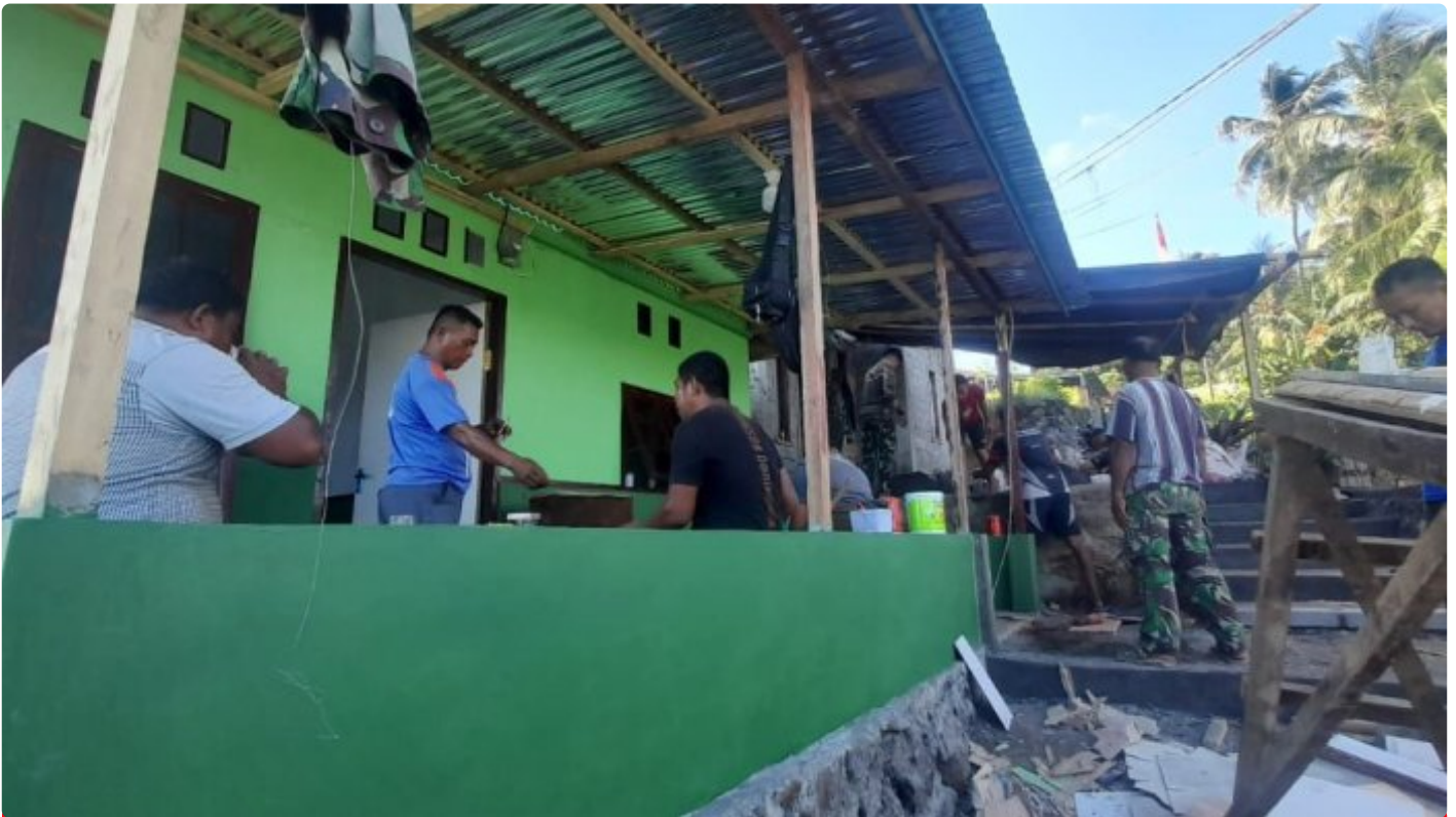
Pembangunan RTLH Keluarga Galvin Karaki pada TMMD Ke-116 Kodim 1310 Bitung
