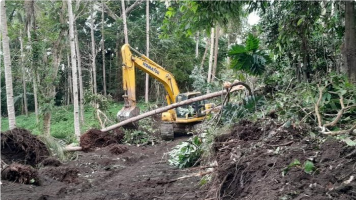
Pekerjaan Infrastruktur Pembukaan Jalan di TMMD Tandurusa
