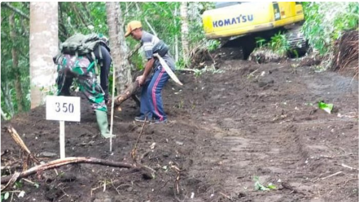
Pembukaan Akses Jalan oleh Satgas TMMD Ke-116 di Kelurahan Tandurusa. capai 350 Meter
