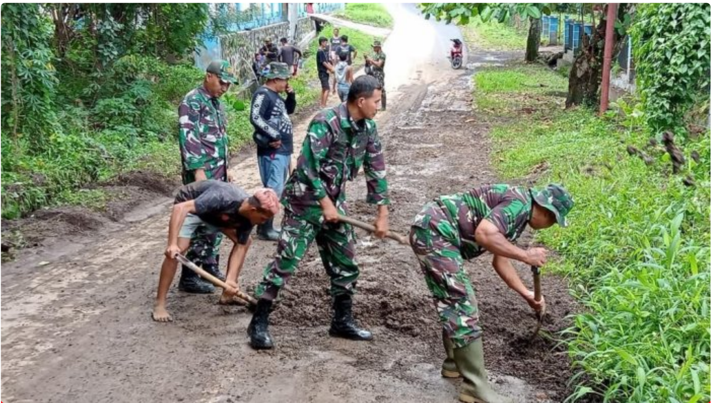
Personil Kodim 1310/Bitung kerja Bhakti bersihkan tanah longsor tutupi akses Jalan
