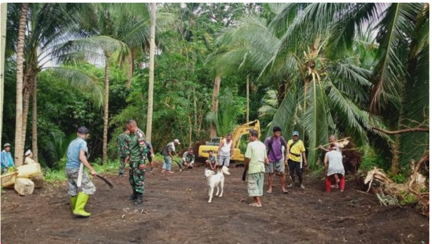
Warga berbaur bersama Satgas TNND Ke-116 Kodim 1310 Bitung dalam kerja Pembangunan Jalan Pertanian
