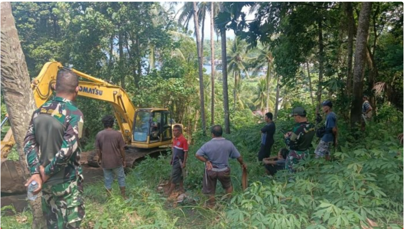
Dan Satgas TMMMD, Dandim Tinjau Pekerjaan Perntisan Jalan Pertanian
