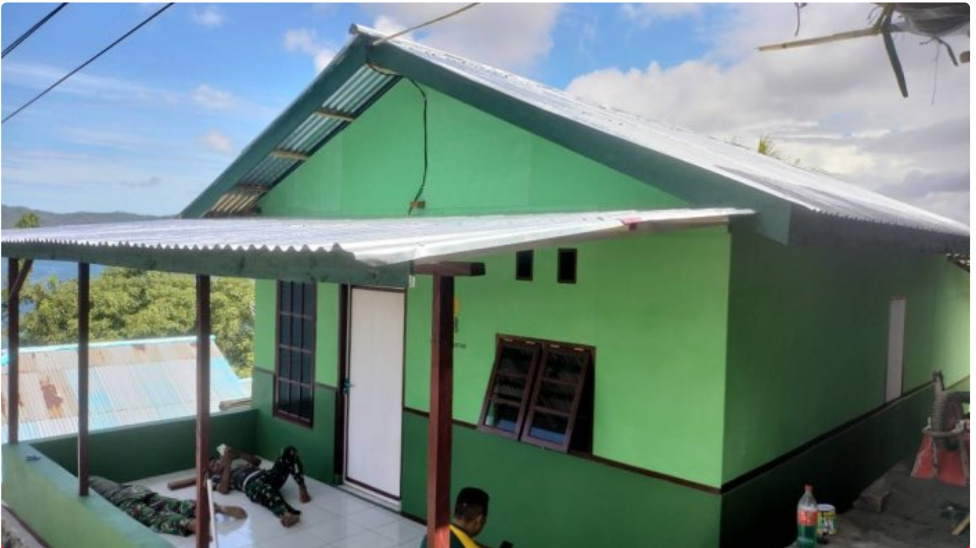
Renovasi RTLH TMMD Ke-116 Kodim 1310 Bitung
